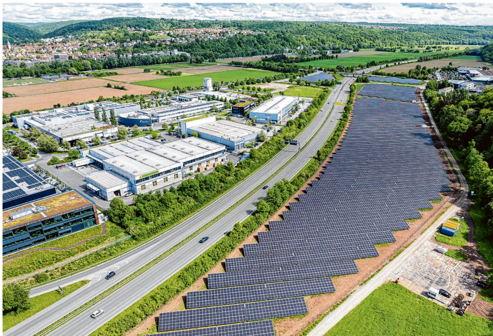
Sichtbares Zeichen der Energiewende: der Solarpark Traufwiesen an der B 27 in Lustnau
